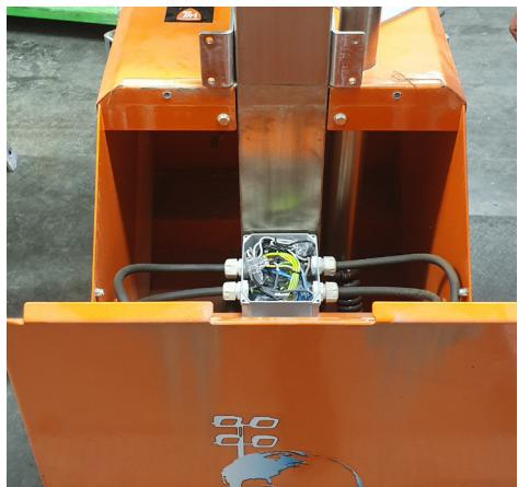
2. Öppna kopplingsdosan och koppla bort alla kablar till ballaster. Koppla ihop inkommande kabel med utgående spiralkabel som är dragen upp i masten i kopplingsdosan eller med snabbkoppling (jordledare, fasledare och neutralledare vidare upp i masten).
